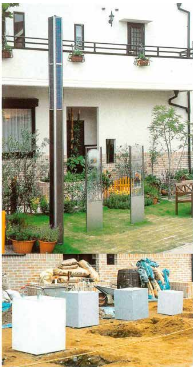
H11.3月施工（施工前）／吹田市ABC千里住宅公園 太陽電池付4m照明柱（計4基）及び1.8mサインディスプレイ（ベースタイプ）
