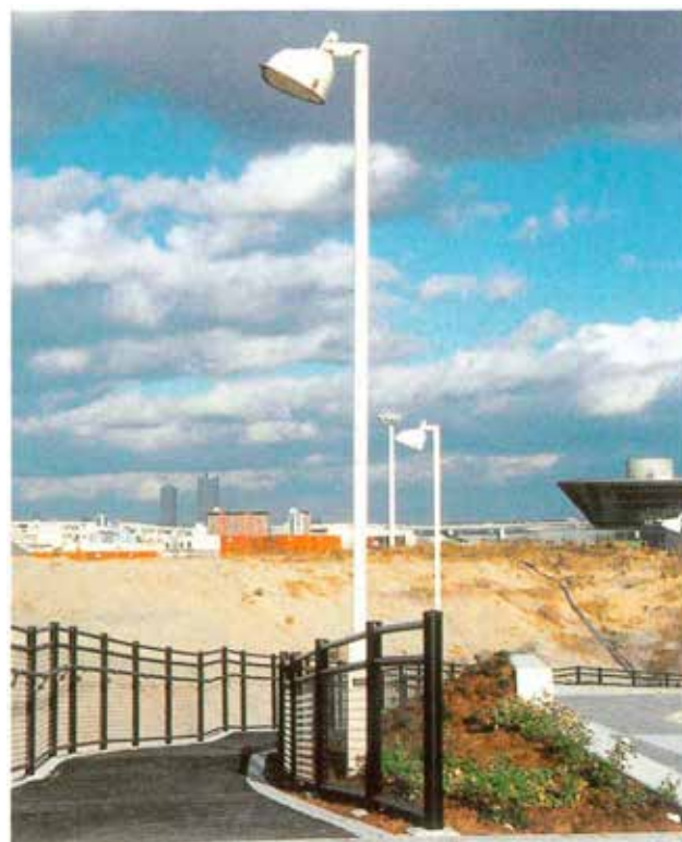
H10.10月施工／大阪市港湾局 5m照明柱（12基）、基礎幅600mm根入れ長900mm（ベースタイプ）
