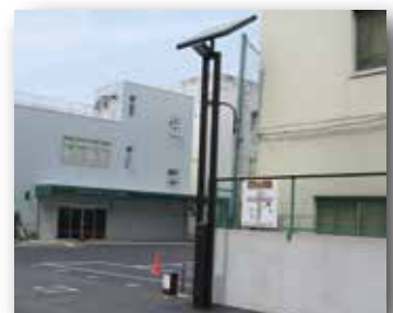
新宿区区役所照明灯
