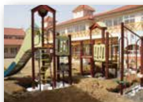
某幼稚園遊具基礎（和歌山県）
