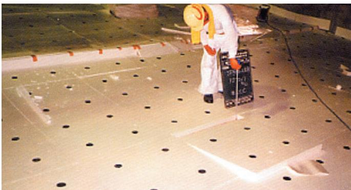
PSブロックは、高発泡高弾性ポリスチレンフォームと防振ゴムを組み合せた浮床用緩衝材で、複合ビルなどの高度な遮音・防振性能が要求される床材に適しています。
