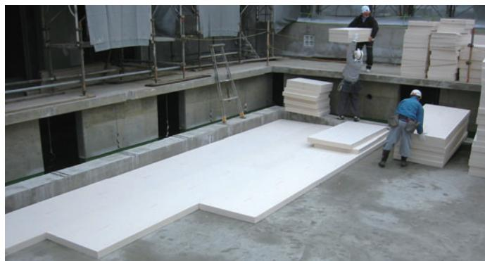
かさあげ用途に開発された、軽くて耐荷重に優れた特性を有する押出法ポリスチレンフォームです。材料の軽量性・圧縮特性・耐水性・加工性を活かし、新設工事や増築・改修工事における低負荷での構造物のかさあげや工期短縮・省力化を可能とします。
